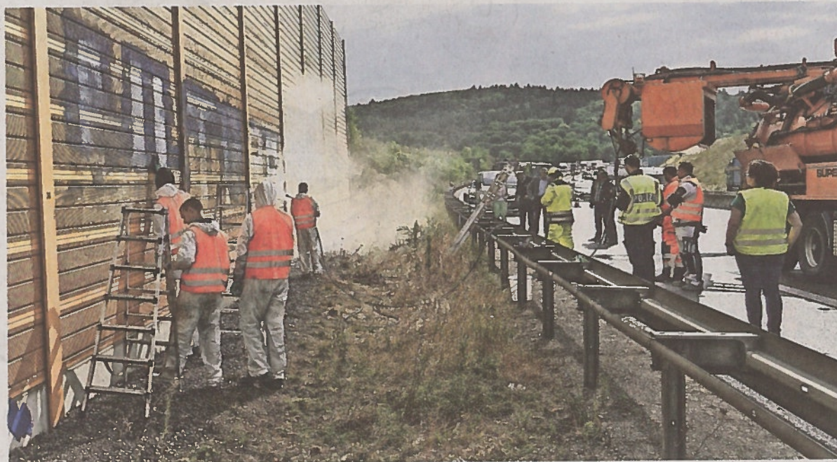
Teile der A8 werden – unter anderem auf der Höhe von Remchingen – für die Aktion gesperrt.
